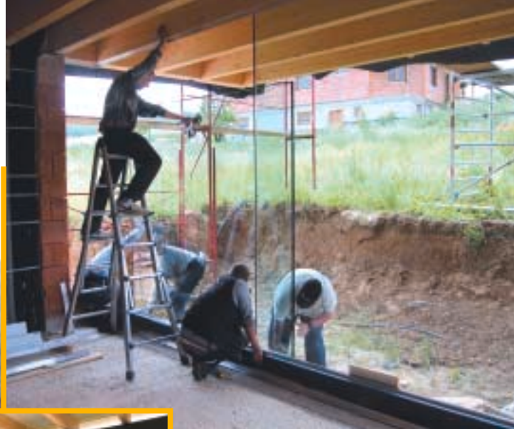
Versetzen der Glaselemente im Wohnbereich. So weit als möglich wurde auf Rahmenverglasung verzichtet. Für die Fixverglasung entwickelte man eigene Anschlussdetails.
