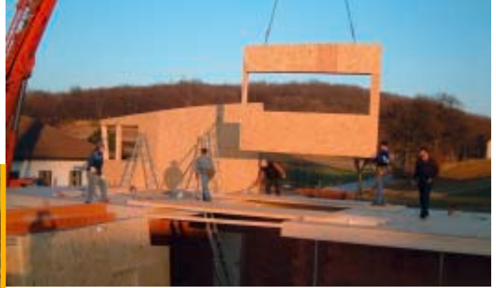
Der Rohbau aus Ziegelwänden (Speichermasse) und Holz-Fertigteilen war in rund zwei Wochen abgeschlossen.
