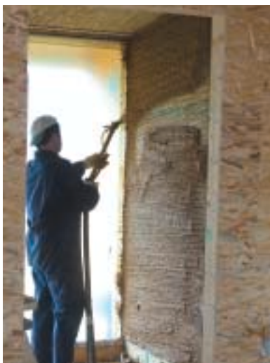
Lehmputz kommt in beiden Geschossen zum Einsatz.
