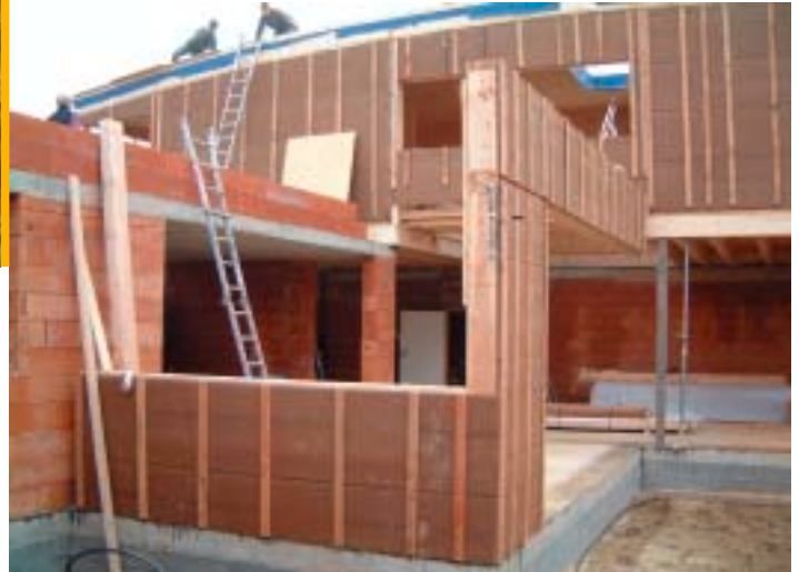
Der Rohbau aus Ziegelwänden (Speichermasse) und Holz-Fertigteilen war in rund zwei Wochen abgeschlossen.
