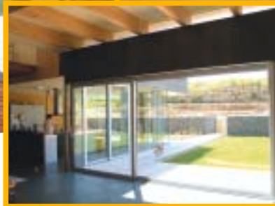
Versetzen der Glaselemente im Wohnbereich. So weit als möglich wurde auf Rahmenverglasung verzichtet. Für die Fixverglasung entwickelte man eigene Anschlussdetails.
